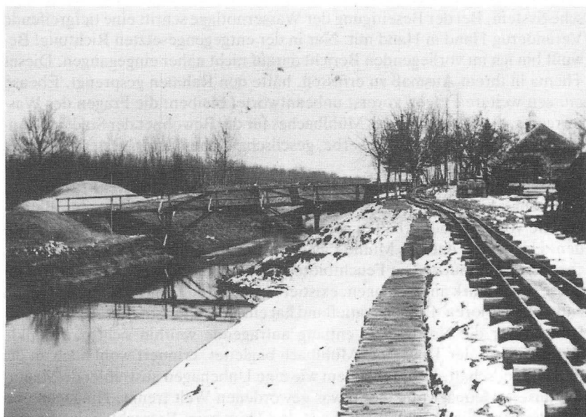
Foto 33: Baustelle an der Pulkau vor dem Försterhaus
