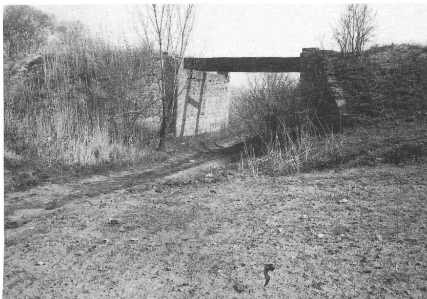
Foto 31: Ehemaliger Durchlaß des alten Siglißgrabens durch den Eisenbahndamm Laa - Höflein; heute liegt ein Feldweg im Bachbett
