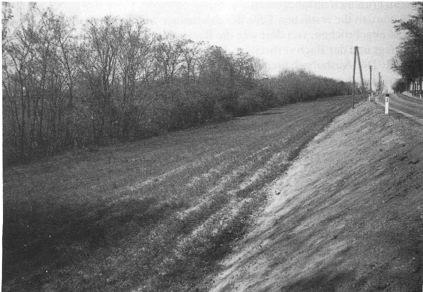
Foto 26: Reste des alten Sieglibaches an der Ruhhofstraße
