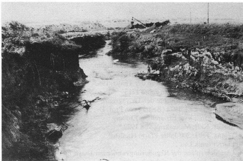
Foto 34: Blick in die mit Schlamm gefüllte Pulkau bei den Regulierungsarbeiten
